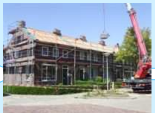
Renovatie De Engel
