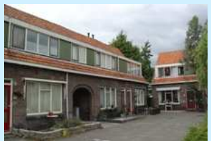
Sloop/nieuwbouw en renovatie wijk Patrimonium
