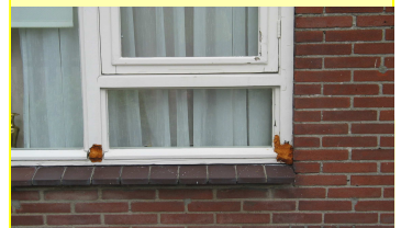
Raamkozijn met rot
